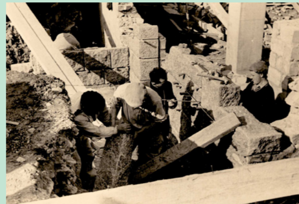
Chantier à Brest © Archives municipales de Brest, photo entreprise Casseau Morlaix, 1952
