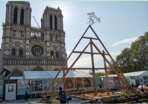
Chantier de Notre-Dame de Paris © D. Vomscheid, 2021
